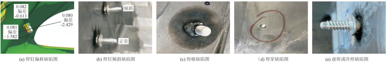
图11 铝螺柱焊接常见的缺陷
